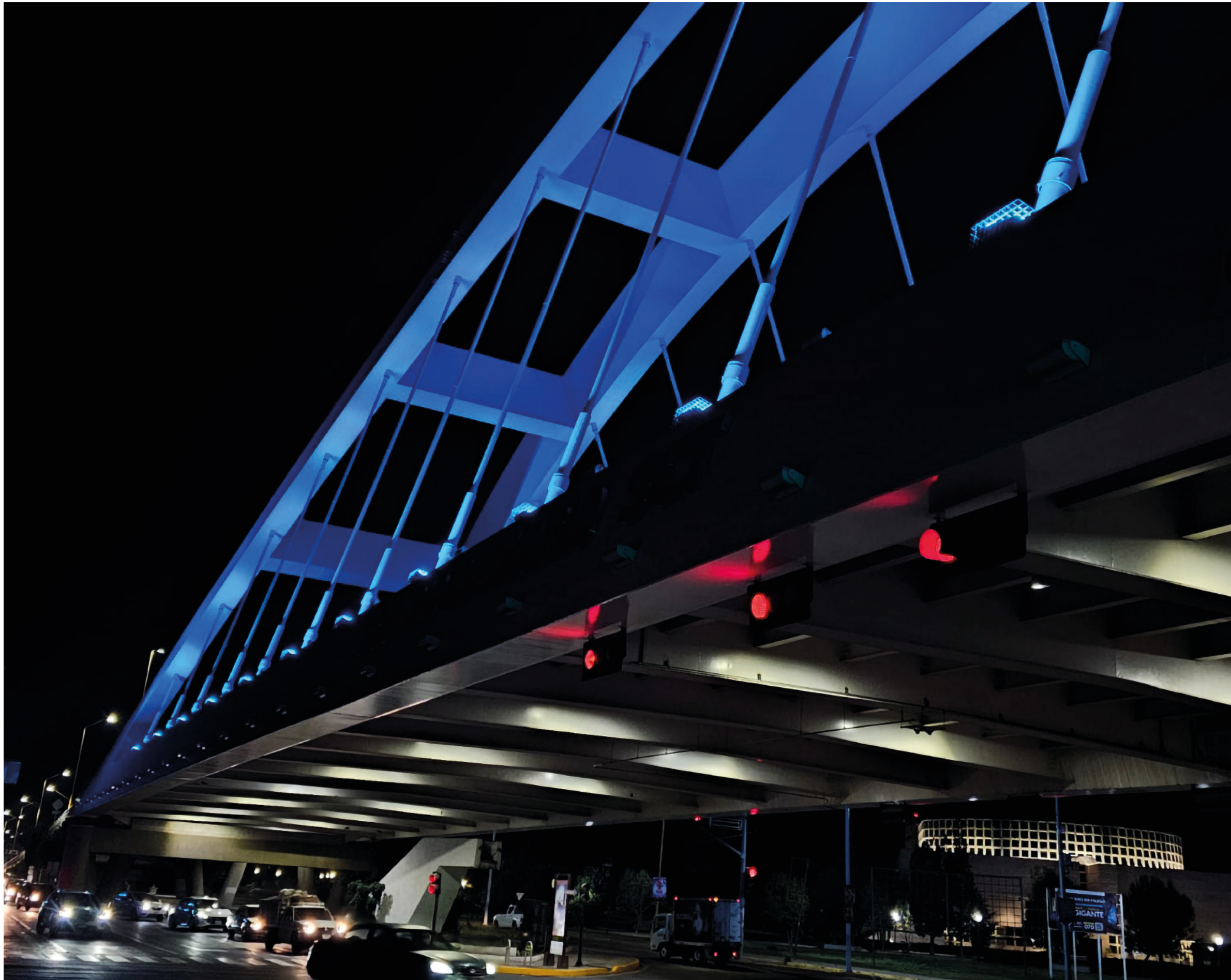
Proyecto: Puente Bicentenario Proyecto Iluminación: STARLUX / HT2 Fotografía: Edgar Del Real
